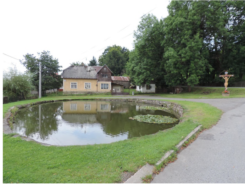
obr. . C.89: Pomník nenápadný dům s polovalbovou střechou na návsi; patrná je pozdější dostavba vpravo (jiný typ okna); poněkud rozpačitě spojí podkrovní dělnářská přístavba, přístavba garáže a dalších doprovodných staveb na pozemku
