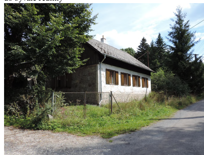
obr. C.35: Přizemní objekt u cesty ze Staré Kníflečí Hutě do bývalé Jedliny
