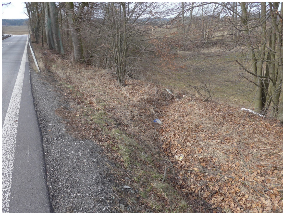
Levá strana L.B překonání periodického příkopu
