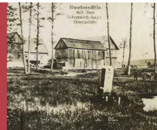
20. budova Huschermühle z roku 1945
